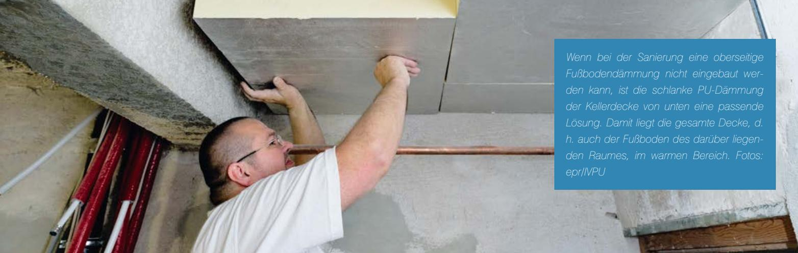
Wenn bei der Sanierung eine oberseitige Fußbodendämmung nicht eingebaut werden kann, ist die schlanke PU-Dämmung der Kellerdecke von unten eine passende Lösung. Damit liegt die gesamte Decke, d. h. auch der Fußboden des darüber liegenden Raumes, im warmen Bereich. Fotos: epr/IVPU
