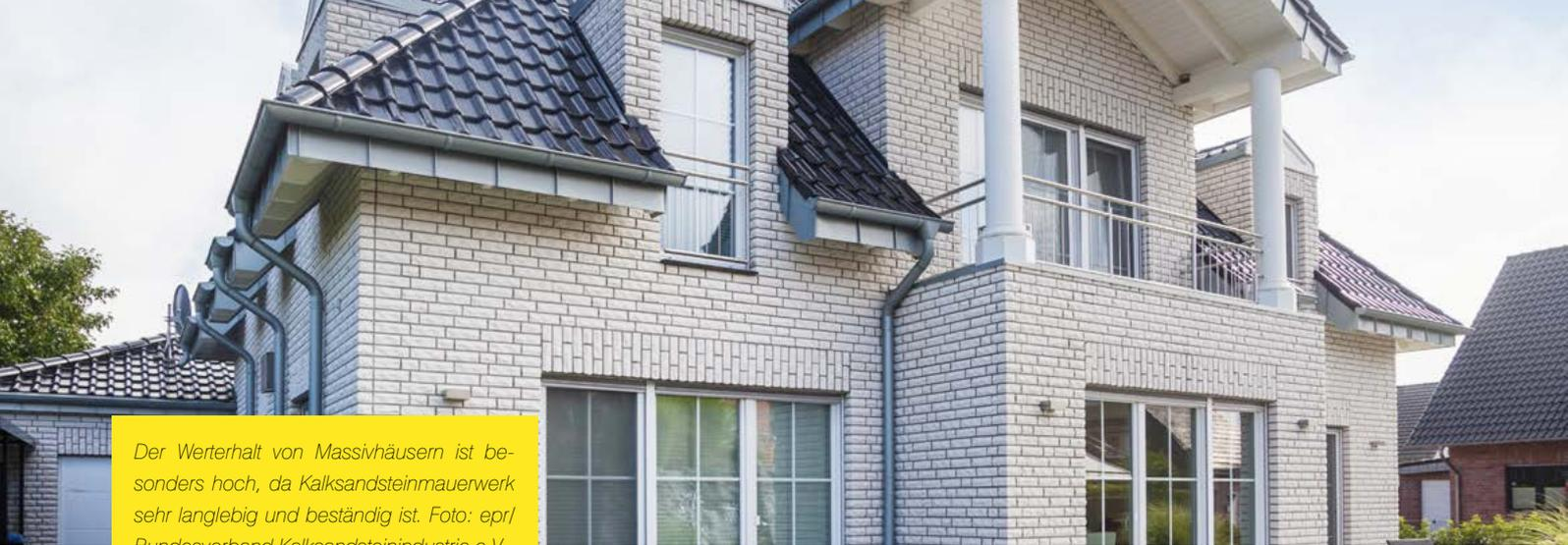
*Der Werterhalt von Massivhäusern ist besonders hoch, da Kalksandsteinmauerwerk sehr langlebig und beständig ist. Foto: epr/ Bundesverband Kalksandsteinindustrie e.V.*
